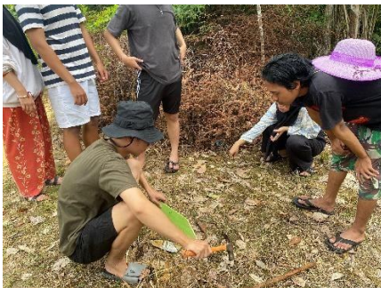
Gambar 2.1. Pembuatan papan arah jalan
