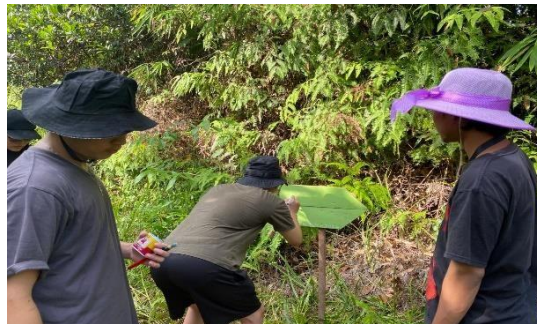
Gambar 2.2. Pemasangan papan arah jalan
