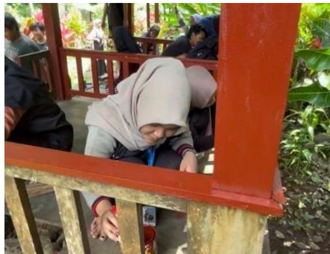
Gambar 3. Pengecatan Gazebo Di Air Terjun Jagir
