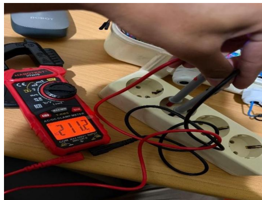
Gambar 4. Pengecekan Menggunakan Tang Ampere
